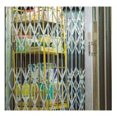
Portes de cabine pliantes de type grillagé à ouverture manuelle.
