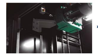
Le moto-réducteur est situé dans la partie supérieure de la structure modulaire, évitant ainsi le besoin d'une salle des machines.
